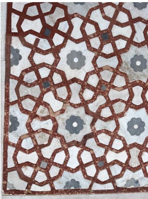
▼ Abb. 12. Inkrustation in Makrana Marmor mit rotem Vindhyan Sandstein und grauem Schiefer, Fassadenelement am Itimad-du-Daula-Mausoleum.
