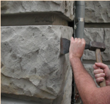
Abb. 2.1 a Oberfläche bossiert; Werkzeuge: Sprengelisen u. Fäustel; Beispiel: Nesselberg Sandstein , Erweiterungsbau TU
