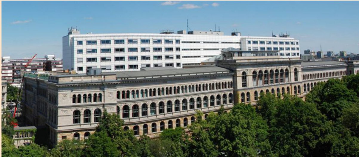
Abb. 5.1 b Hauptgebäude von Südwesten gesehen (vom BH Gebäude aus). Man erkennt deutlich im Vordergrund die nach dem Krieg wieder hergestellten Teile des Altbaus mit dem Übergang zum Erweiterungsbau (links unten). Dahinter erhebt sich der 1963 - 1968 anstelle der stark zerstörten Bauteile errichtete Neubau des Hochhauses mit den 2007/2008 südlich vorge-setzten Aufstockungen.
