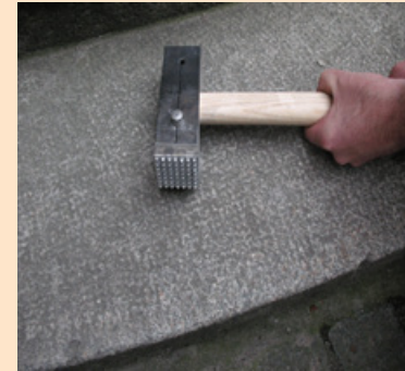
Abb. 2.1 d Oberfläche gestockt; Werkzeug: Stockhammer Beispiel: Granit-Stufe Erweiterungsbau TU [Fotos a - d: Schirrmeister]
