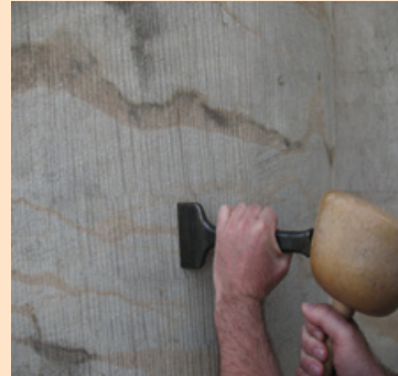
Abb. 2.1 c Oberfläche scharriert; Werkzeug: Scharriereisen und Knüpfel (aus Holz); Beispiel: Postaer Sandstein , St. Hedwigs-kathedrale
