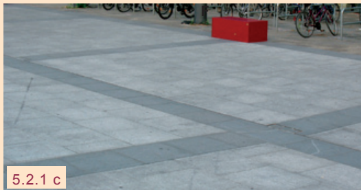
Abb. 5.2.1 b - d Vorplatz des Hauptgebäudes belegt mit gesägten Platten von chinesischen Tiefengesteinen: dunkelgrau: Diorit Padang Dunkel G 654 ; hellgrau: Granit Padang Cristal G 603 - Stein Information: Herkunft: Provinz Fujian, S. China; Alter: Kreide-Zeit.
