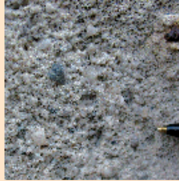
<< Abb. 1.2 d Sedimentgestein: Ibbenbürener Sandstein , grob- körniger = kiesiger Bereich, Erwei- terungsbau, Altbau, Fassade (5.3.4)
