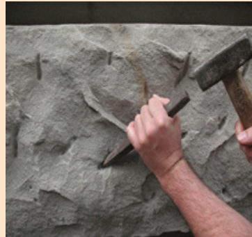
Abb. 2.1 b Oberfläche gespitzt; Werkzeuge: Spitzeisen und Fäustel; Beispiel: Nesselberg Sandstein , Erweiterungsbau TU
