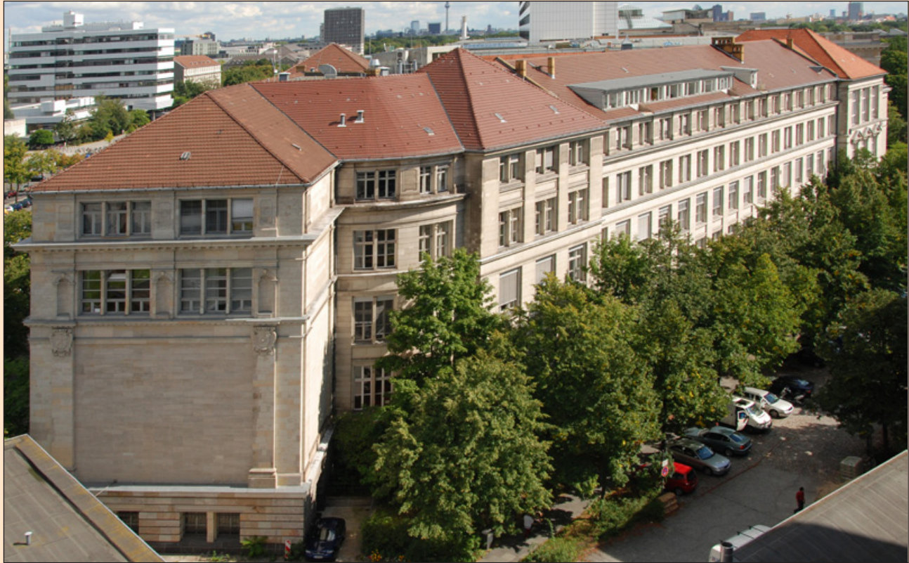
Abb. 5.3 b Erweiterungsbau der TU von Südwesten aus gesehen (vom Gebäude für Berg- und Hüttenwesen); man sieht vor allem den 1912 - 1916 erbauten Teil mit der Fassade aus Cottaer Sand- stein . [Foto: E. Weiss]
