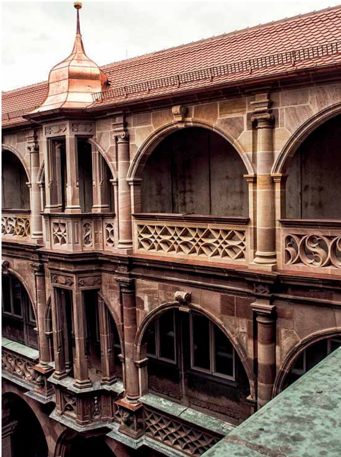
Abb. 2.: Für den Wiederaufbau des Pellerhofs in der Nürnberger Altstadt, der bis zu seiner Zerstörung im Zweiten Weltkrieg als eines der bedeutendsten Bürgerhäuser deutscher Renaissancekunst galt, wurden über 900 Steinquader des Nürnberger Burgsandsteins aus dem Steinbruch Worzeldorf zu Maßwerken, Säulen sowie profilierten Bogen- und Gesimssteinen verarbeitet. In der Bauzeit von 2009 bis 2018 wurden so Werksteine mit einem Gesamtvolumen von 220 \text{ m}^3 verbaut. Alle Sichtflächen wurden handwerklich, frei von Hieb auf Vorlage historischer Baupläne und alten Bildmaterials originalgetreu nachgearbeitet (Photo GS Schenk; aus GRIMM 2018).
