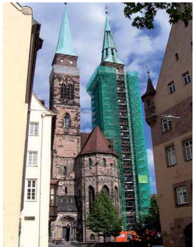
Abb. 4: Blick auf St. Sebald mit eingerüstetem Südturm (Foto: Fritsch, Knodt & Klug, 2007).
