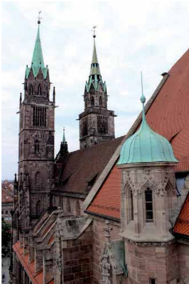
Abb. 2: St. Lorenz Blick von Arbeitsbühne. Nach Westen zu den Türmen von St. Lorenz (Foto: Conn & Giersch, 2017).
