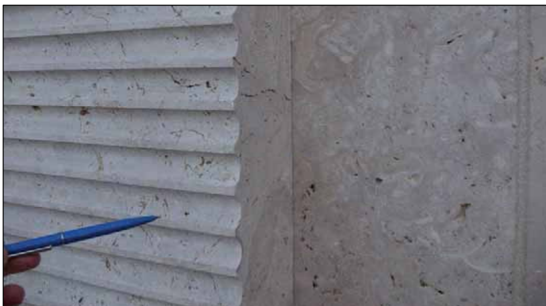
Tafel-1: Zoofenster von Christoph Mäckler (2009-2012) am Breitscheidplatz mit Fassadenteil aus Marchinger Trosselfels .
