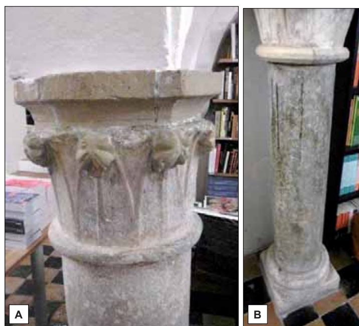
Abb. 1: A- Kapitell auf aus oolithischem Baumberger Kalkstein; B – Säule aus magmatischem Gestein.
