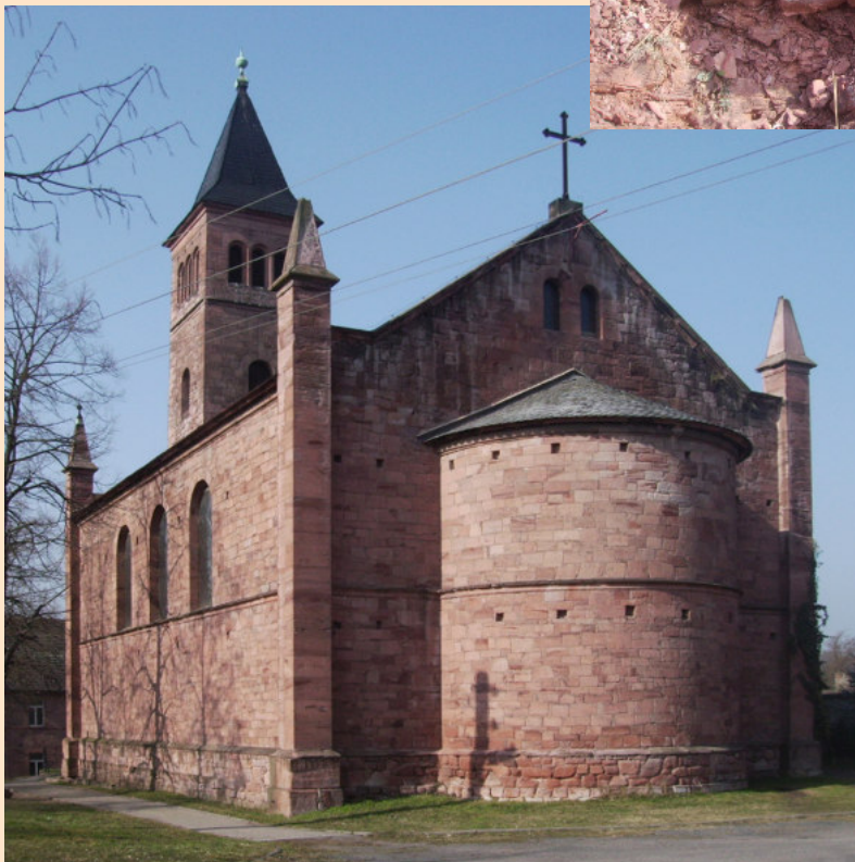
<<< Abb. 4: Kirche in Rothenburg (Neuromanisch 1840) mit lokalen Bausteinen im Fundament.
