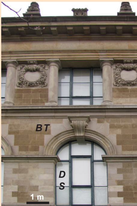
<<<< Hauptfassade mit Deister Sandstein (DS) und Brohler Tuffgestein (BT)
