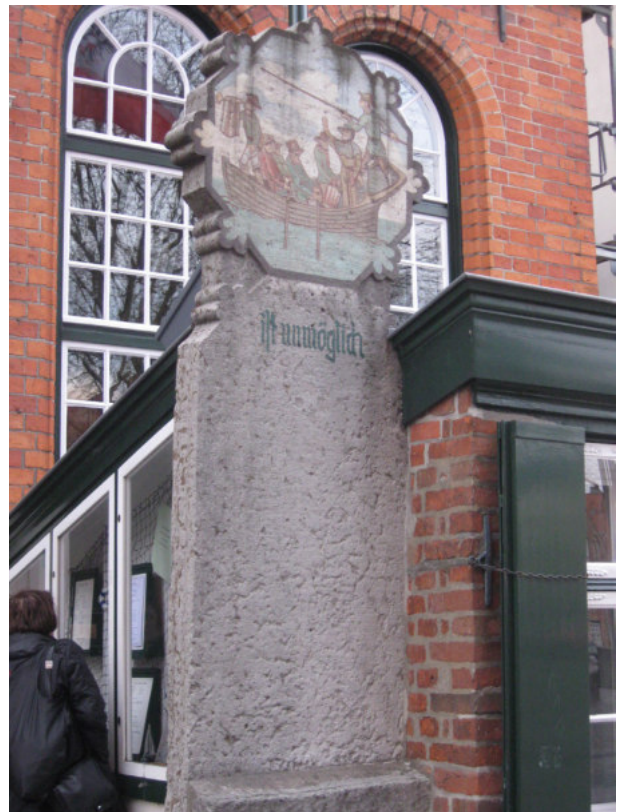
Beischlagwangen aus öländischem Kalkstein am Eingang zur Schiffergesellschaft (Foto: GeoPark Nordisches Steinreich)
