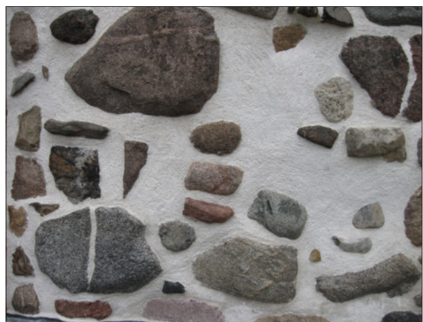
Sanierung mit Gipsmörtel an der Kirche Ratekau Foto: GeoPark Nordisches Steinreich
