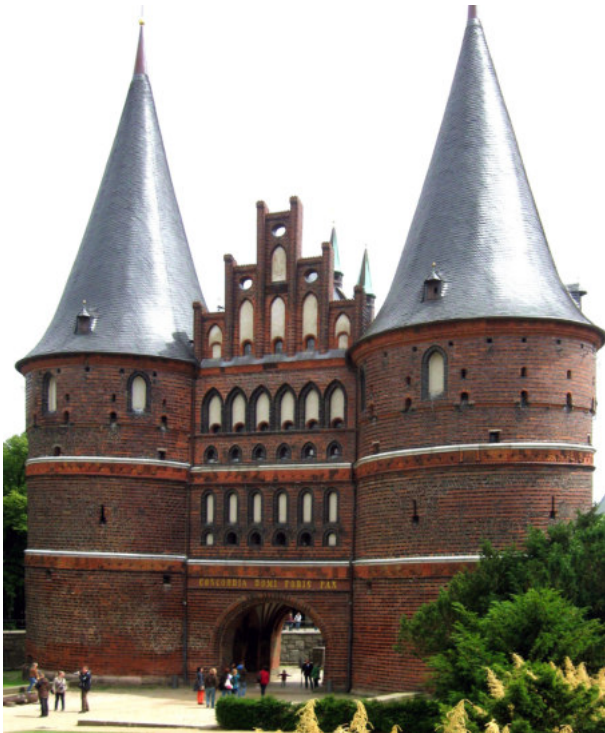
Das Wahrzeichen Lübecks: das Holstentor - auf Torf gebaut (Foto: GeoPark Nordisches Steinreich)
