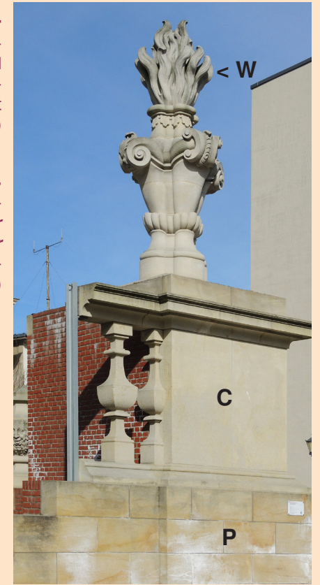
Abb. P 5 Alte Wache Ecke Charlottenstr./ Lindenstr. mit Säulen sowie Dachskulptu- ren aus Magde- burger Sand- stein [Foto: Bolze]
