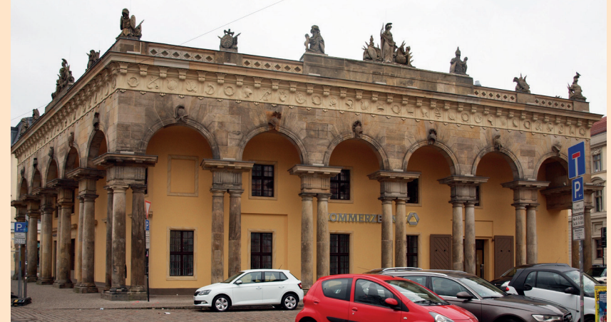
Abb. P 5 Alte Wache Ecke Charlottenstr./ Lindenstr. mit Säulen sowie Dachskulptu- ren aus Magde- burger Sand- stein [Foto: Bolze]
